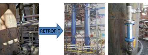
Fig.7 Retrofit de las columnas de concentrado final de cobre
